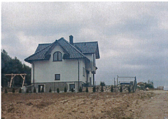
Fot.3. Zabudowa mieszkaniowa jednorodzinna na działce nr 24/3.
