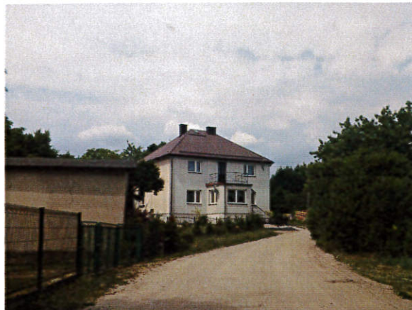
Fot.2 Budynek mieszkalny w zabudowie zagrodowej na dz. nr 176.
